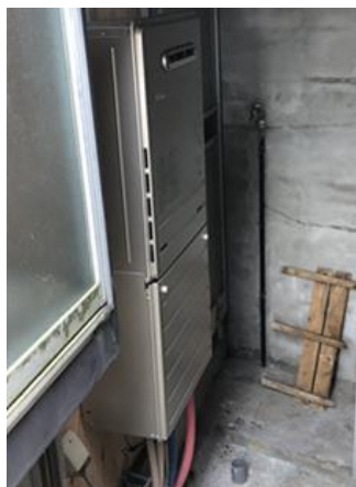
△ボイラーの設置
