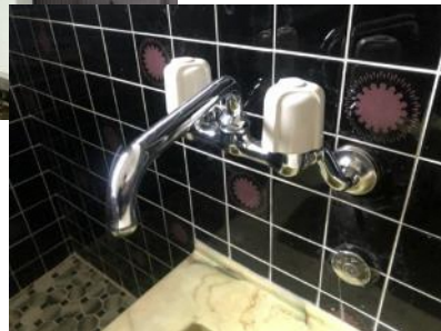
▽風呂場給水栓取換
