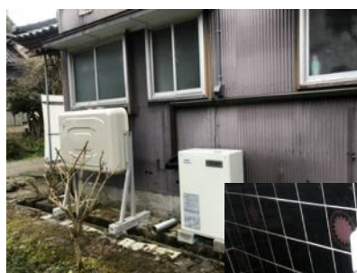
△ボイラー等設置
