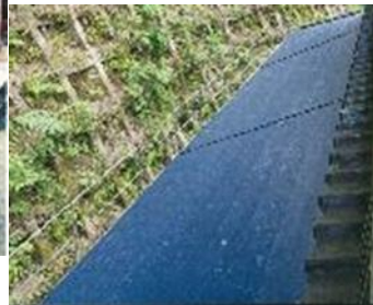
▽下屋根の吹き替え
