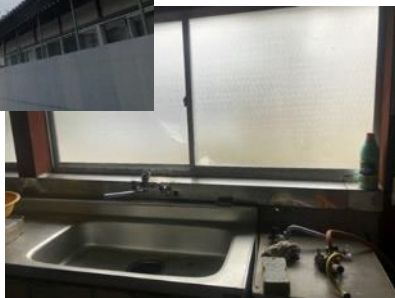
▽既存給湯器撤去
