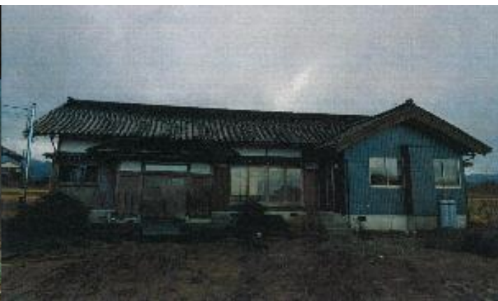
△改修後: 建物外観(全体)
