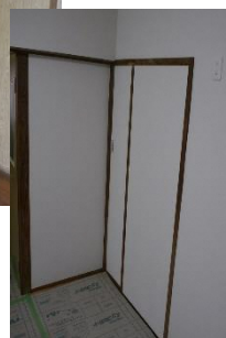
△改修後: 内装仕上げ
